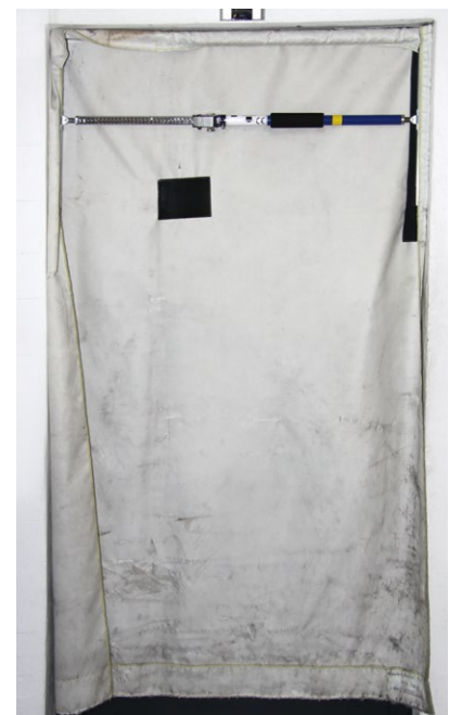
Obturbateur mobile de protection contre la fumée
