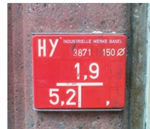
Plaquette signalétique pour hydrante souterraine (indique l'emplacement de l'hydrante)
